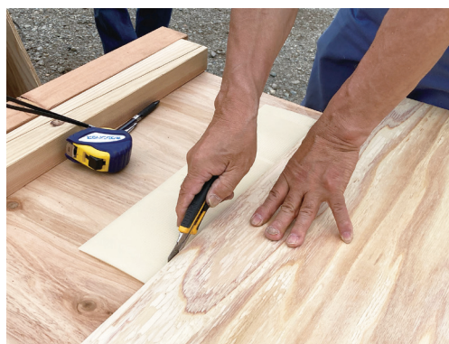
パッサーモシートの 寸法カット例
